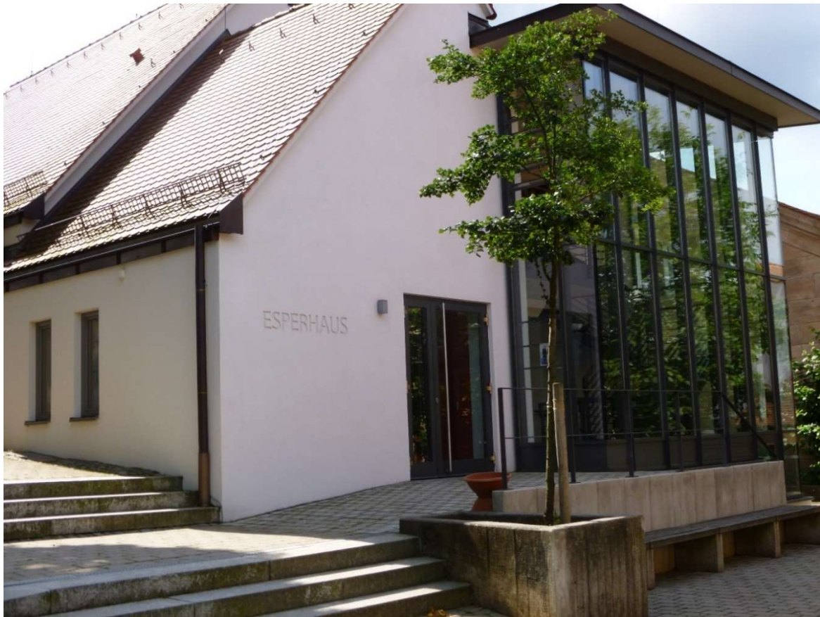
Westfront mit Eingang zu unserem Gemeindehaus („Esperhaus“). Es entstand 2009 aus dem alten Gemeindehaus durch Umbau und Erweiterung.
