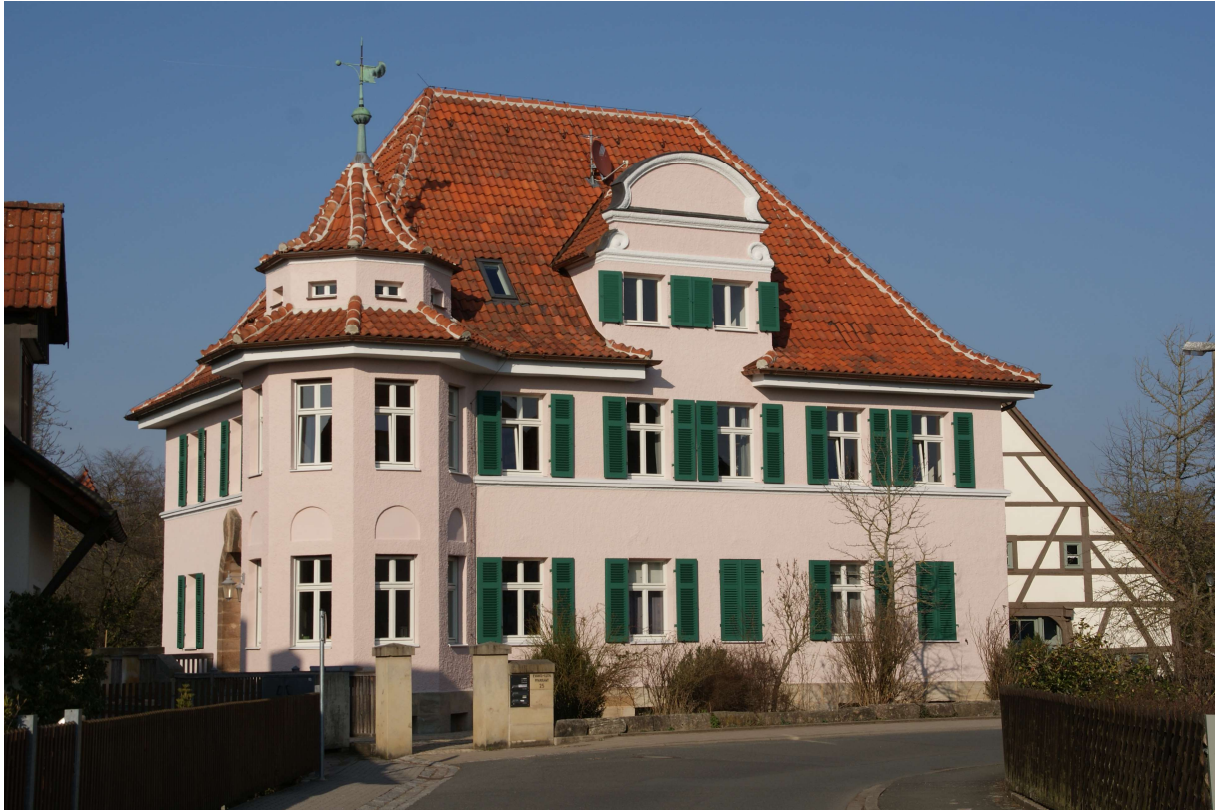
Pfarrhaus nach der Renovierung 2018 (Bild: Rüger privat)
