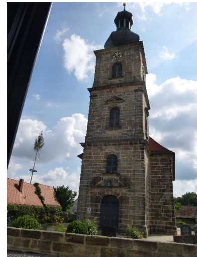
So blickt man durch das Fenster auf unseren Kirchturm
